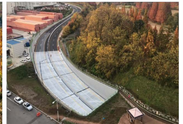
수도권복합물류터미널 확장진입도로 건설공사 2010.02~2019.01
