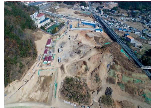
부산장안지구 택지개발사업(2단계) 조성공사 2018.08~2022.07
