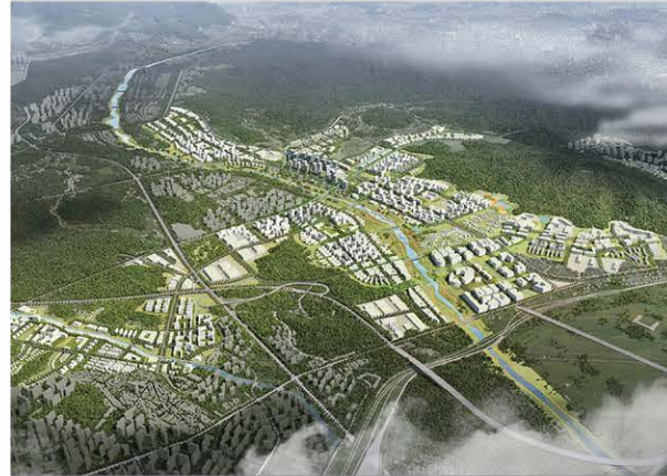
고양창릉 공공주택지구 조성공사(1공구) 2023.05~2028.09
