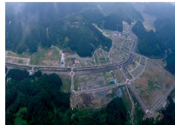
포항블루밸리 개발사업 1단계 조성공사(2공구) 2014.10~2018.09
