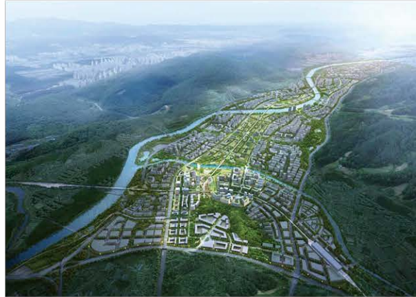
남양주왕숙 공공주택지구 조성공사(3공구) 2023.06~2028.06
