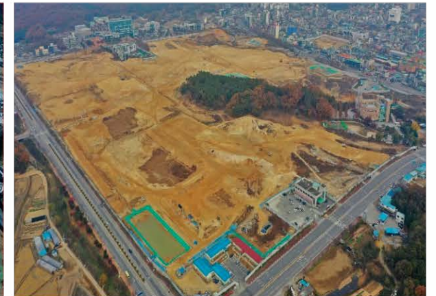
이천중리 택지개발사업 조성공사 2018.10~2022.12
