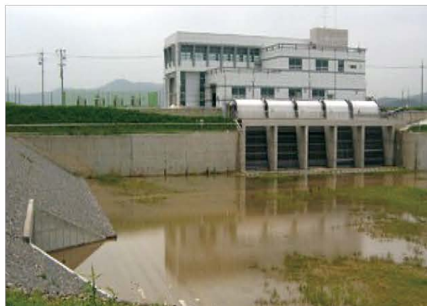
하빈 배수펌프장 설치공사 2004.03~2008.07
