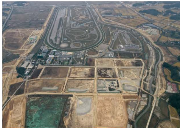
송산그린시티 남측지구 조성공사(2공구) 2017.03~2025.09
