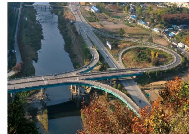
점촌-문경간 도로 4차선 확포장공사 1993.12~1999.12
