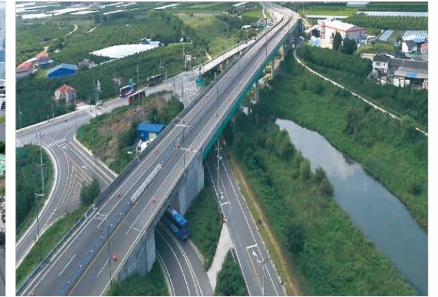
청도-경산간 도로 4차로 확포장공사 2004.04~2016.05
