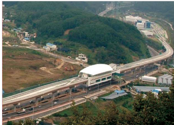
부산 3호선 2단계 328공구 토목공사 2004.04~2010.12
